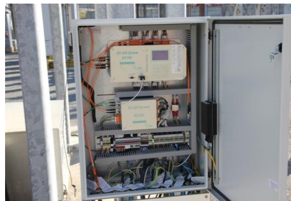
Figura 6: Particolari di installazione sensori/moduli per la diagnostica di interruttori in AT
