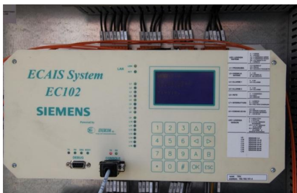
Figura 6: Particolari di installazione sensori/moduli per la diagnostica di interruttori in AT
