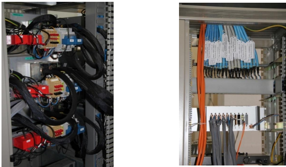
Figura 5: a) particolari delle installazioni di sensori/moduli per la diagnostica in MT - Sensori MT (retro protezioni MT) e b) modulo diagnostica MT (n° 6 stalli)
