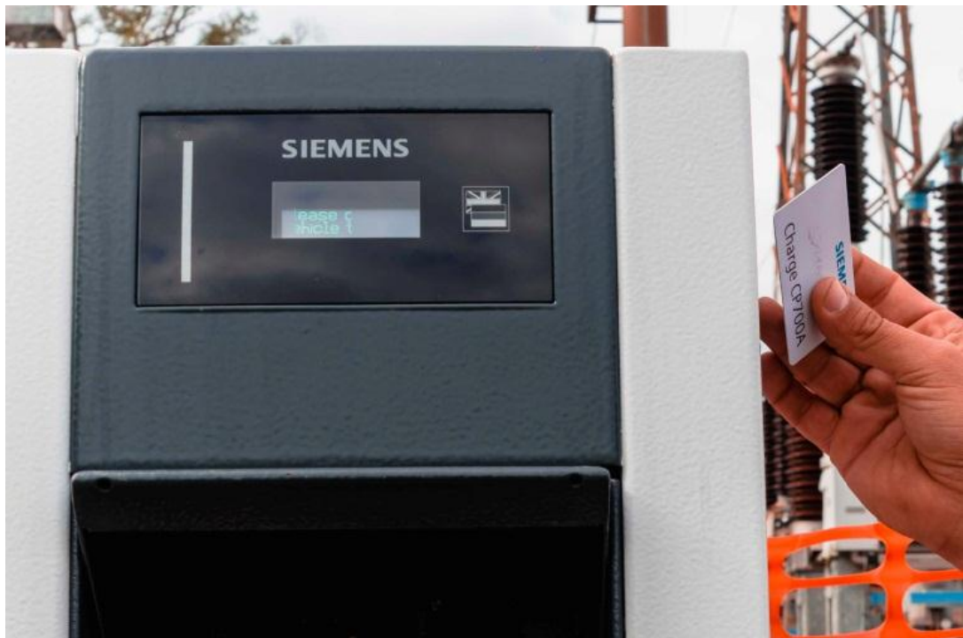
Figura 32: Riconoscimento tessera RFID da parte della colonnina di ricarica
