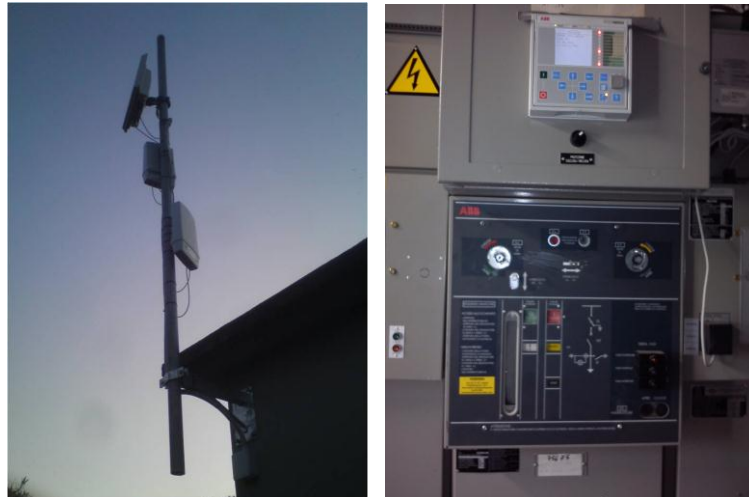
Figura 1: a) particolare antenna hiperlan, b) particolare recloser
