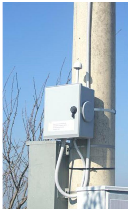
Figura 7: Rilevatori dei punti di innesco installati sulla dorsale Malagrotta
