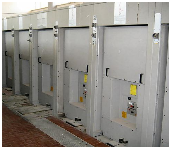
Figura 18: CP Raffinerie-Quadri MT
